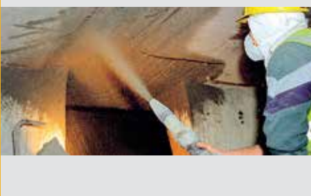
Ремонт и защита бетона
